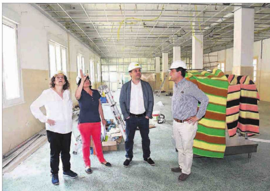
Goretti Sanmartín, primera por la izquierda, en su visita a las obras de la residencia del Calvo Sotelo. | VÍCTOR ECHAVE
