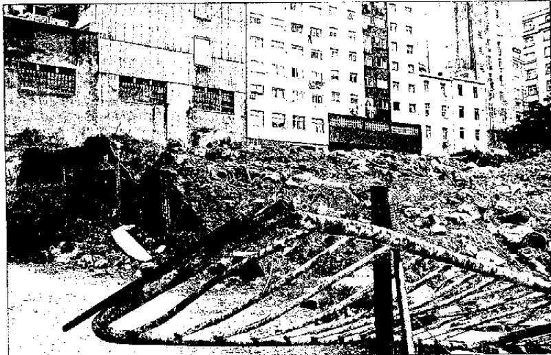
El solar que corta la calle Rey Abdullah es una escombrera que lleva años abandonada
