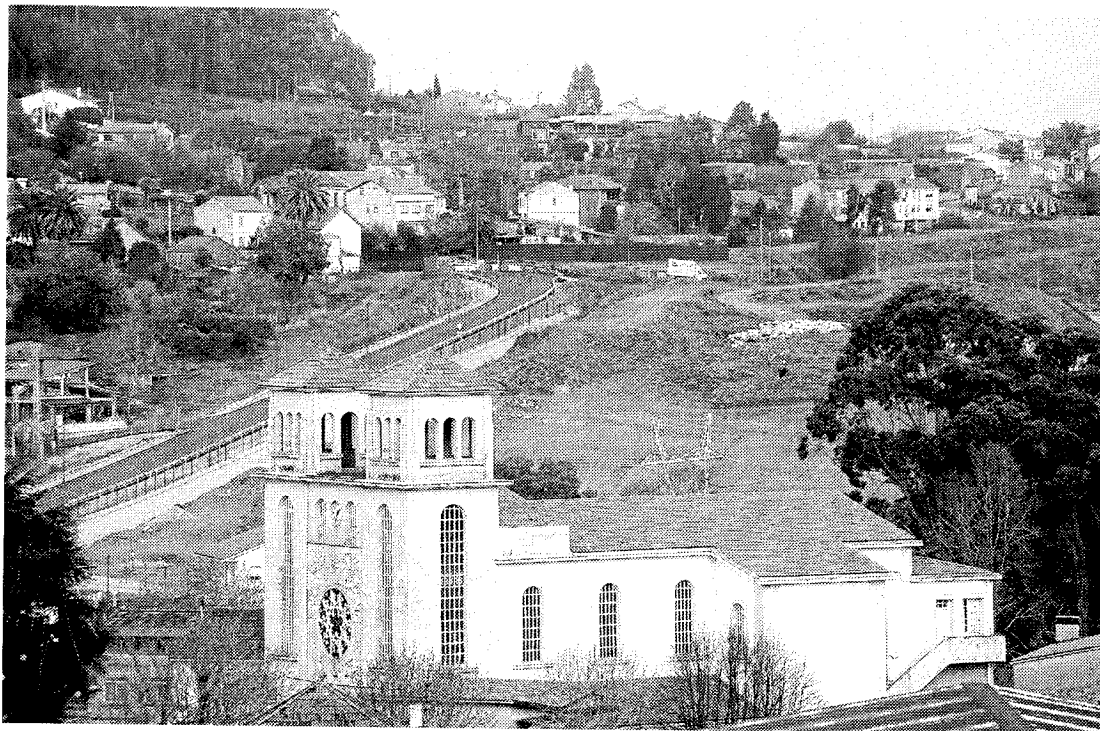
La carretera está construida, pero el ente provincial exige su adecuación a las obras
