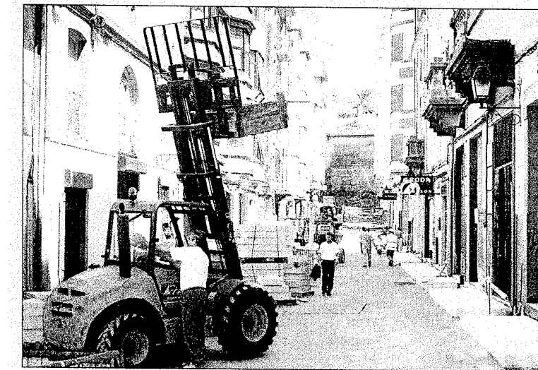
Los operarios empezaron ayer por la mañana las obras de renovación de las aceras / Quintana
